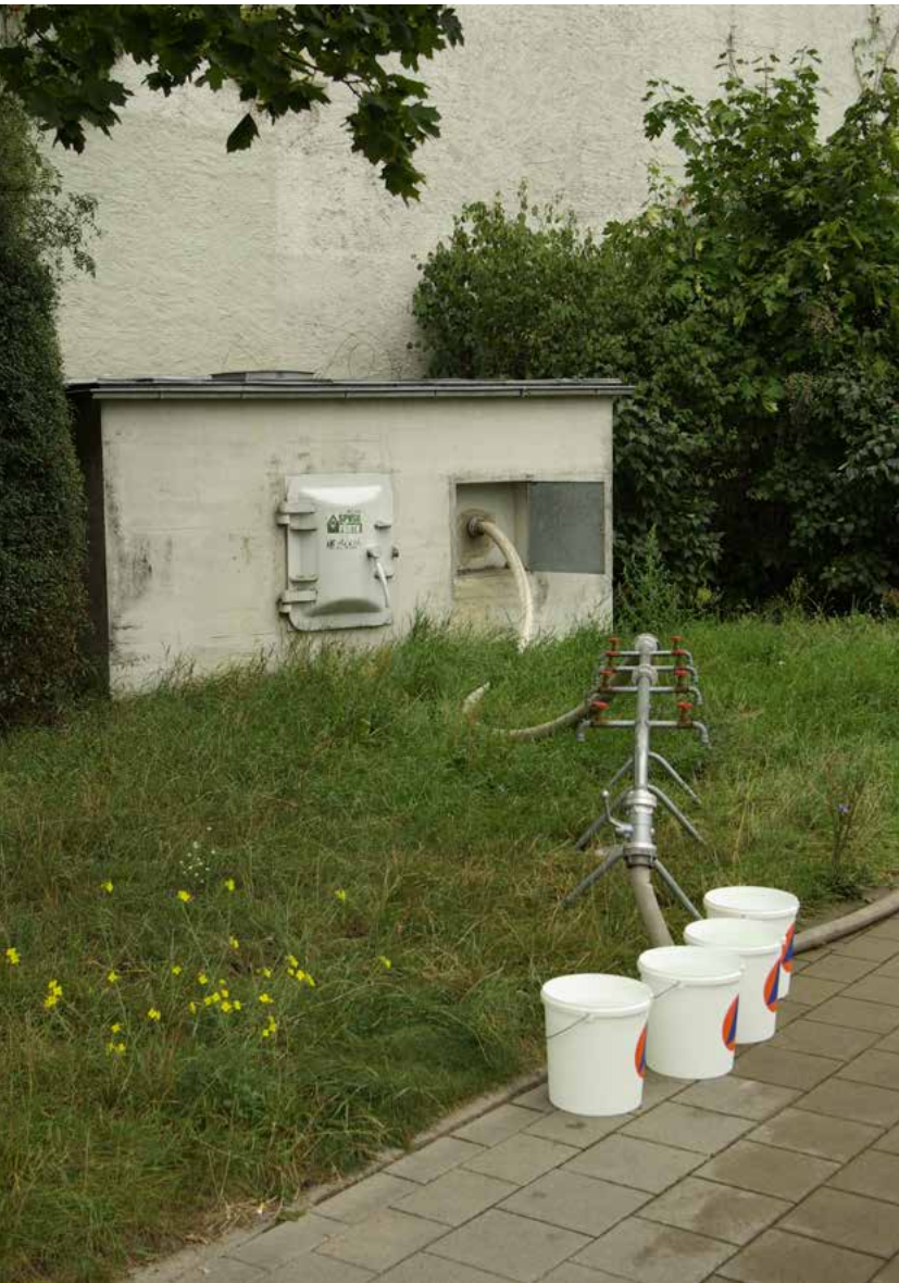
Trinkwassernotbrunnen in Fürth. (Bild: Wiki Commons, Janericloebe)
